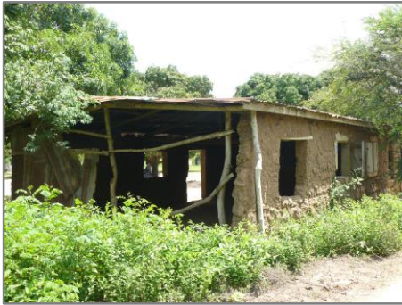
Schulgebäude in Teglou-Aglata
