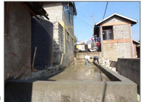
Die Basis für die Wassertanks ist fertig
