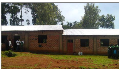
Schulgebäude in Kisii
